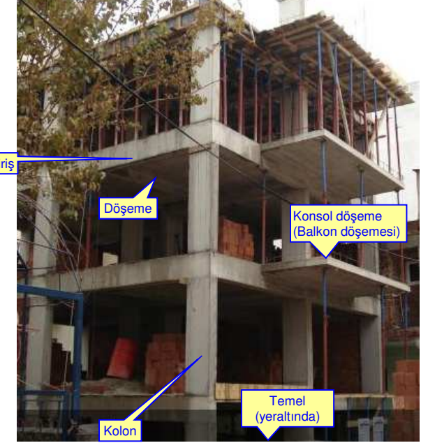
Betonarme taşıyıcı sistem
